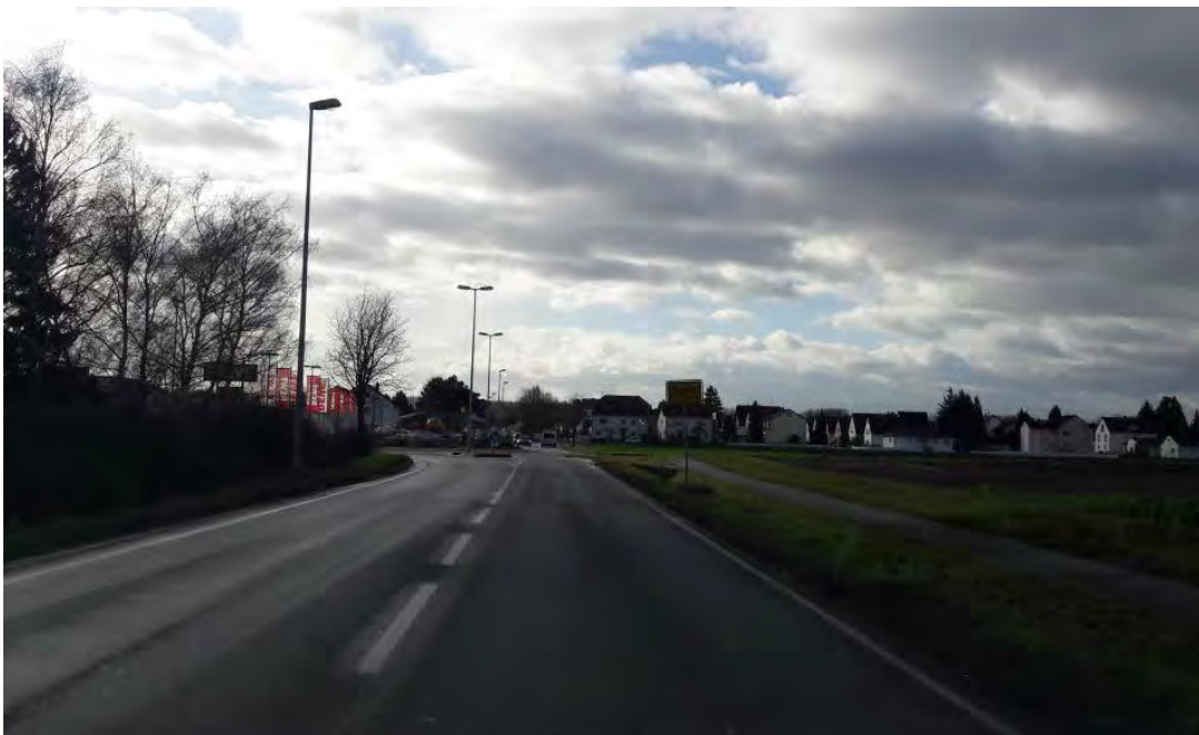
Abbildung 2.2: Fotodokumentation – L 3012 (Blickrichtung nach Süden)
